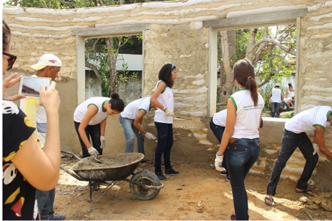
Figura 33: Rebocando as paredes da Biblioteca
