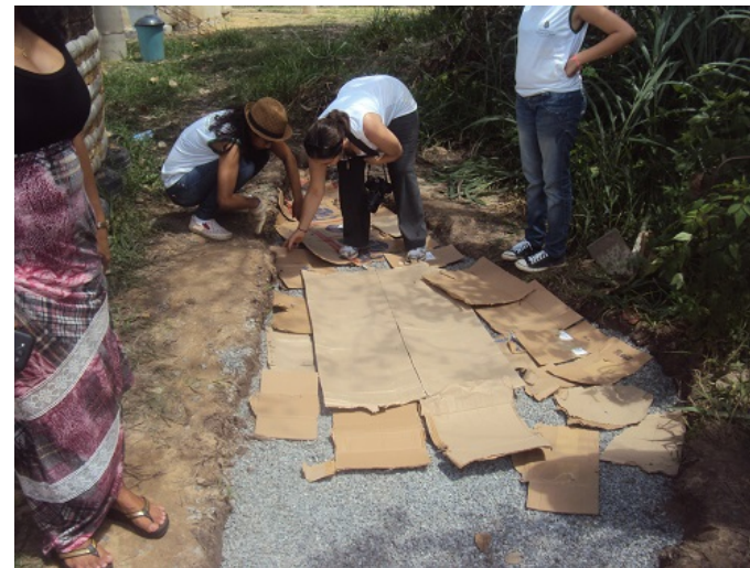
Figura 32: Construindo Jardim de Chuva
