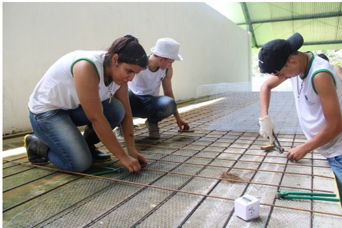
Figura 34: Preparando Malha para Ferrocimento
