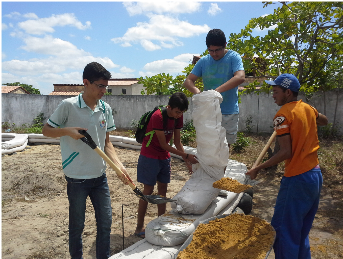
Figura 50: ] Aprendendo a construir com hiperadobe - Escola Jaime Laurindo, Barroquinha 49
