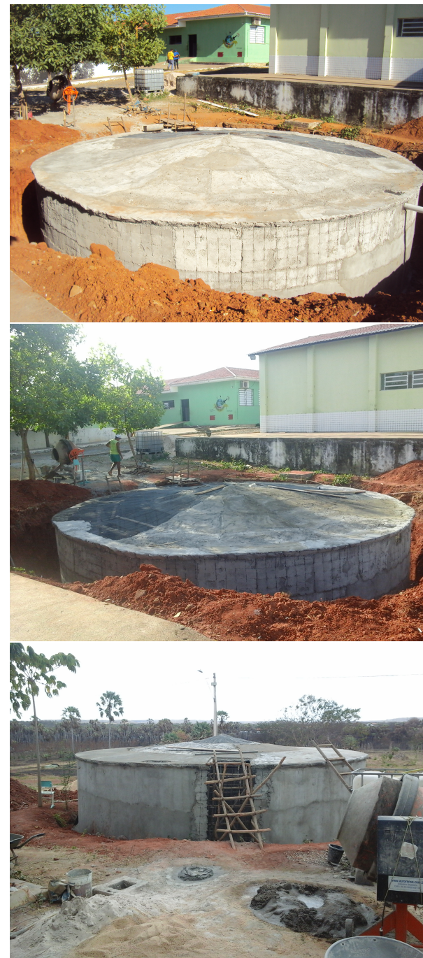
Cisternas sendo construídas a EEEP Guilherme Teles Gouveia (Granja)
